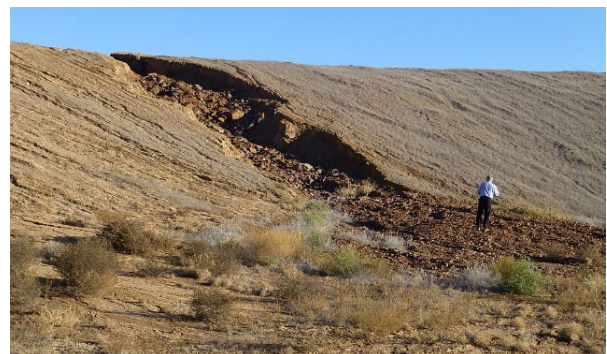
Eine Erosionsrinne auf einer Uranbergbauhalde in Südkasachstan.
