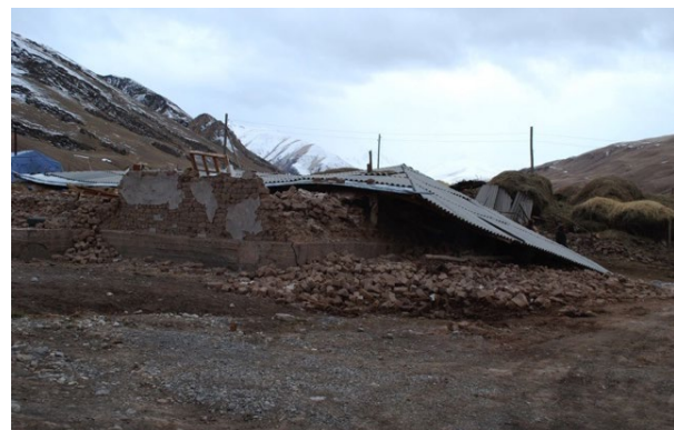
Durch ein Magnitude 6,8 Nura Erdbeben zerstörtes Gebäude in Kirgistan.
