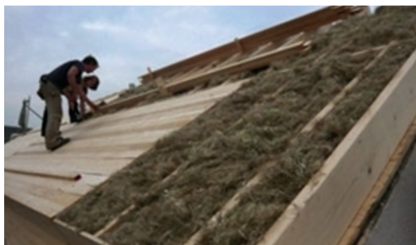
Dachdämmung mit Bastfasern.
