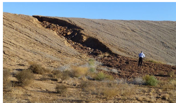
Eine Erosionsrinne auf einer Uranbergbauhalde in Südkasachstan.
